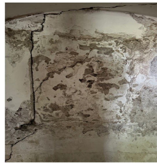
binnenzijde kelder tpv nieuw raam
