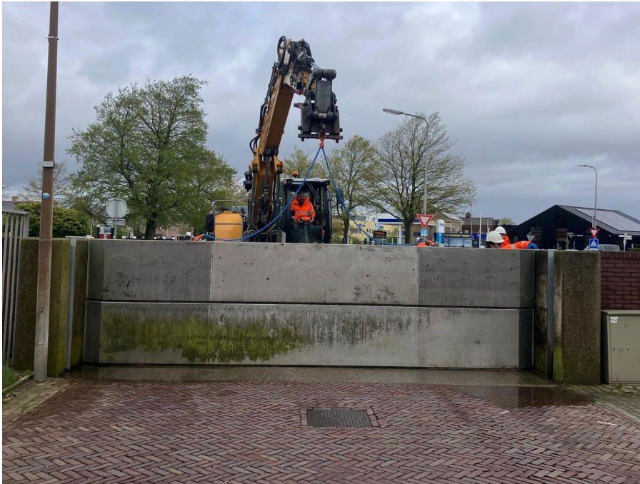
Figuur 7 De coupures op Urk worden gesloten als onderdeel van de jaarlijkse proefsluiking
