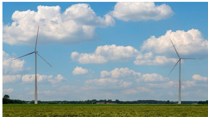
Figuur 2 Molens Windpark Hanze die het waterschap van duurzame energie voorzien
