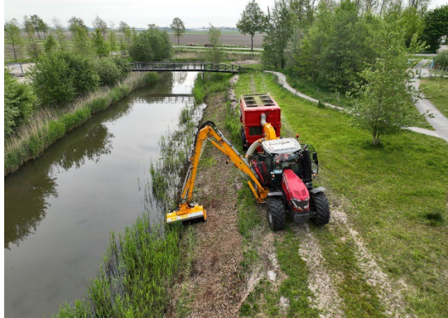
Figuur 9 Maaien en ruimen van het droge talud
