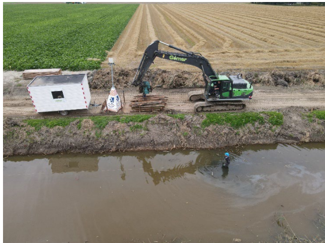
Figuur 8 Vervangingsonderhoud van een oeverbeschoeiing
