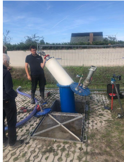
Figuur 14 Inspectie koppelleiding op Urk
