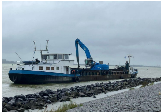
Figuur 5 Het aanvullen van stortsteen langs de Noordermeerdijk
