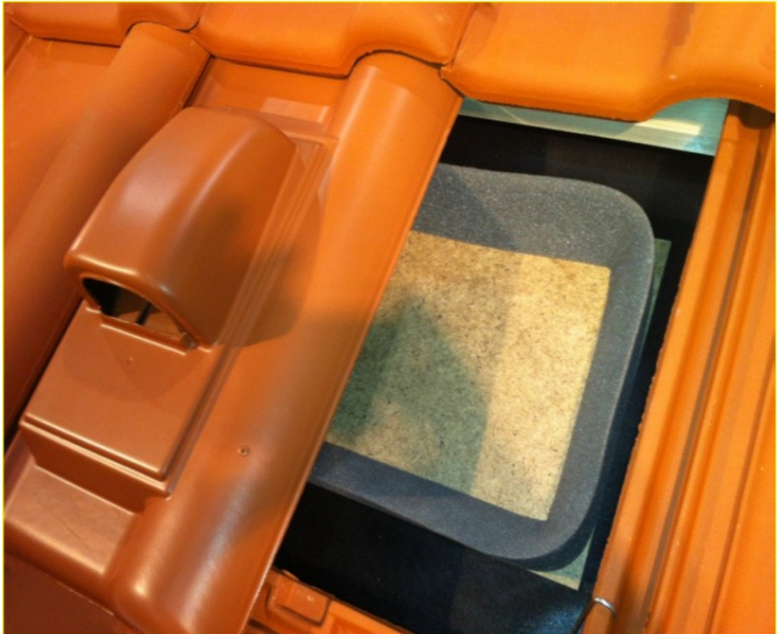
Figuur 2: Colorvent vogelpan van de firma Nedsale. De achterliggende nestpan wordt bij deze renovatie niet gebruikt.
