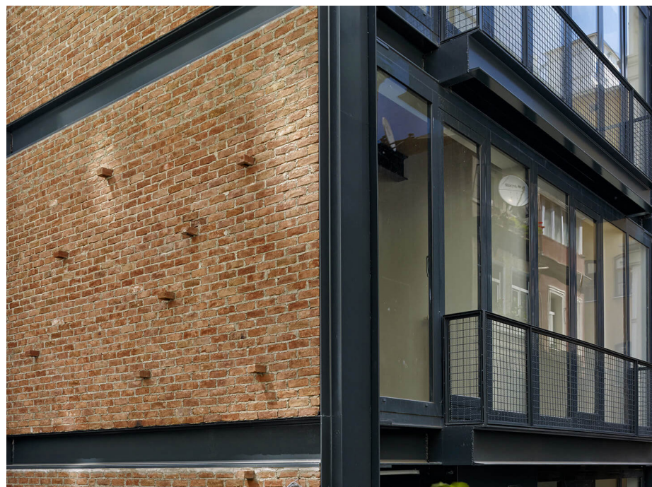
Staal profielen verwerkt als gevelbanden
