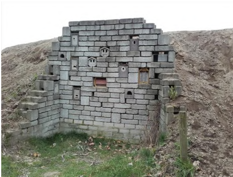
Figuur 15: Wand met diverse voorzieningen voor fauna. Bron foto: https://www.waymarking.com/waymarks/WMQNQC_Steen_en_natuurmuur_Meinweg_Herkenbosch_NL
