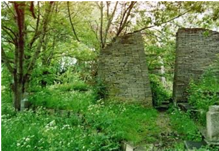
Figuur 13: Ecokathedraal Mildam. De stenen zijn hier zonder metselwerk op elkaar gestapeld. Hierdoor kan de natuur haar gang gaan tussen de stenen. Bron foto: Wikipedia.
