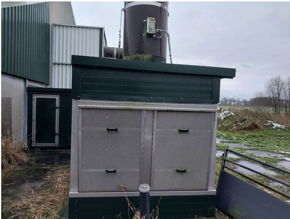
Warmtewisselaar achter stal 1 (zijaanzicht)
