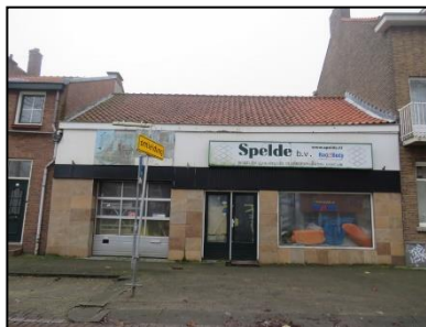
Figuur 3. Vooraanzicht van de bebouwing, gezien vanaf de Dordtsestraatweg.
