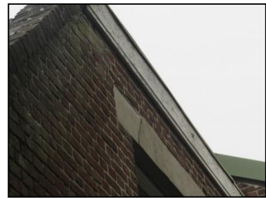
Figuur 16. Ruimte tussen de nok en de binnenzijde van het dak bij betimmerde schuur (nummer 3).
