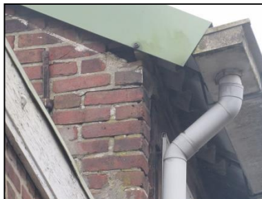
Figuur 14. Opening onder daklijst van betimmerde schuur (nummer 3).
