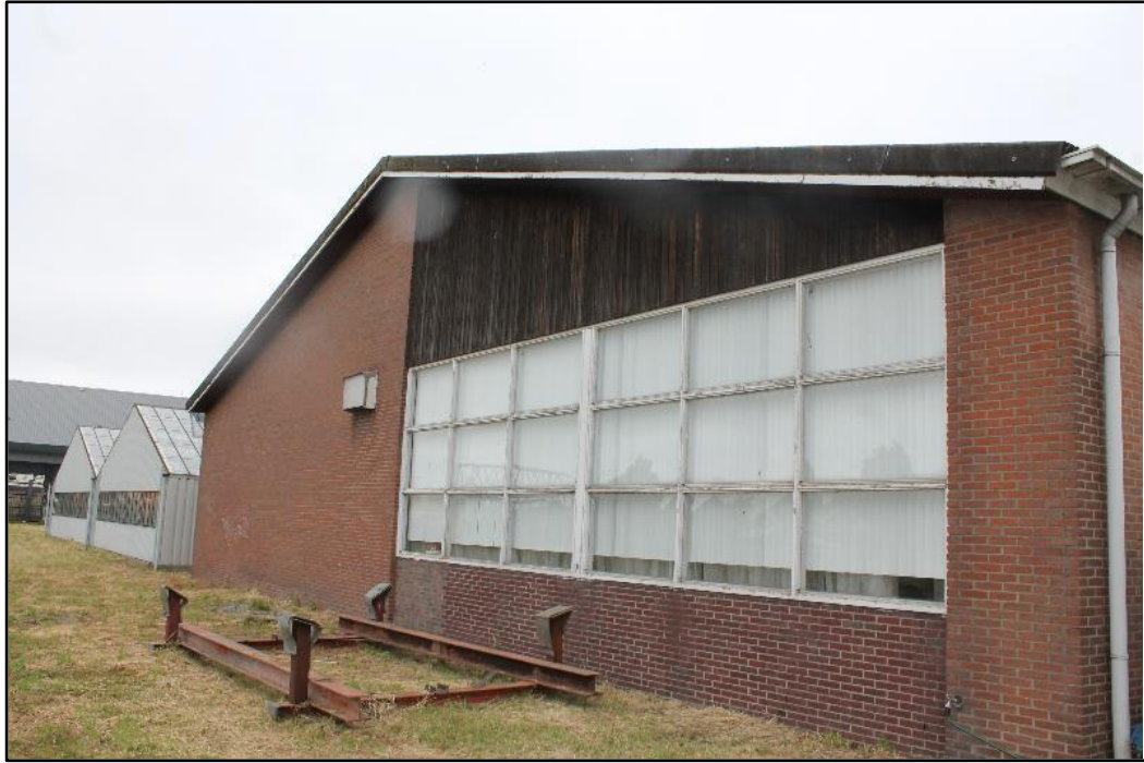
Figuur 1.3 De te saneren loods, opgetrokken uit gemetselde muren met spouw en zadeldak met bitumen dakbedekking (Schrader, 2018).
