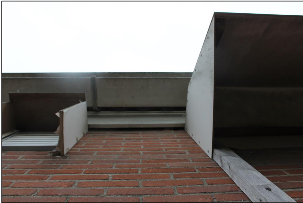
Figuur 1.4 Aan de loods zijn openingen aangetroffen in de vorm van kierende daklijsten. Deze openingen kunnen vleermuizen ruimte verschaffen voor eventuele verblijfplaatsen in de dakruimte of in de spouw. Geschikte openingen in de woning betreffen openingen in de overstekken en kierende kantpannen.
