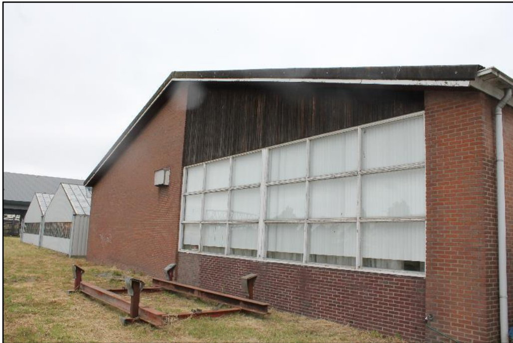
Figuur 1 De planlocatie is gelegen aan de Rijksstraatweg 63 te Sassenheim. Op het perceel staan een loods (rechts op foto) en kas (links op foto). De loods bestaat uit gemetselde muren met spouw en heeft een bitumen zadeldak. De kas is gebouwd uit metalen platen en heeft een glazen zadeldak.
