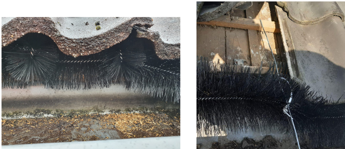
Figuur 4 Dichtzetten van goot met spouwborstels; borstels met harde haren (max 12 cm doorsnede) en korte borstels in holtes om goed af te dichten (rechts) (Bron: Loo Plan) Vastzetten met borstelhaak ter voorkoming loshalen door vogels of marters (links) (Bron: Unitura)
