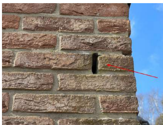
Afbeelding: Open stootvoeg dat toegang zou kunnen geven aan de spouw. Plangebied - rode contour.
