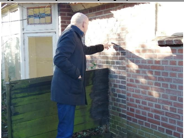
verschillende bouwfases zichtbaar in gevel boerderij
