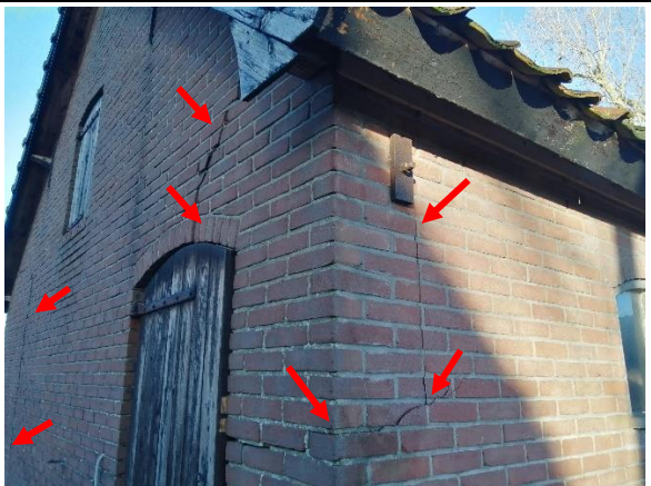
Rondom in de gevels varkensschuur scheurvorming
