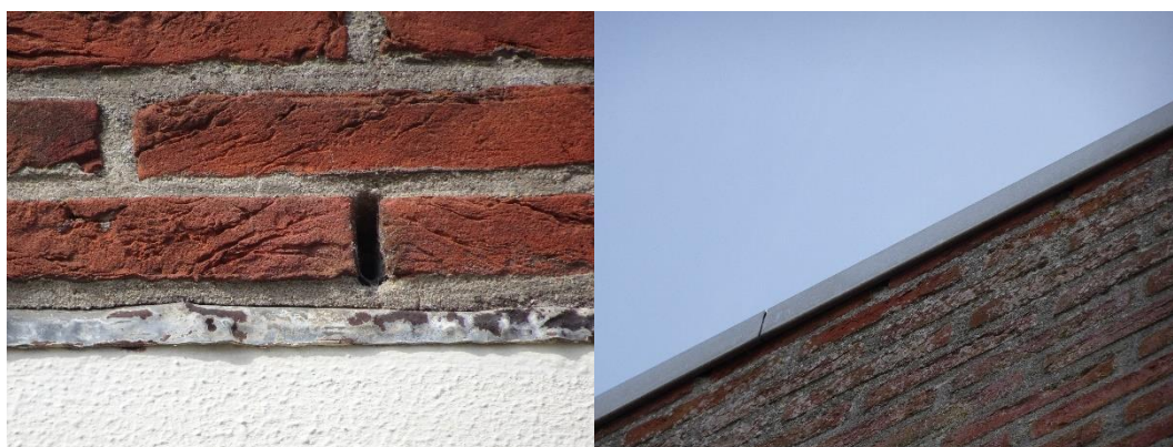
Figuur 3.9 Open stootvoeg en opening onder daklijst in kantoorpand P069 in Noordwijk
