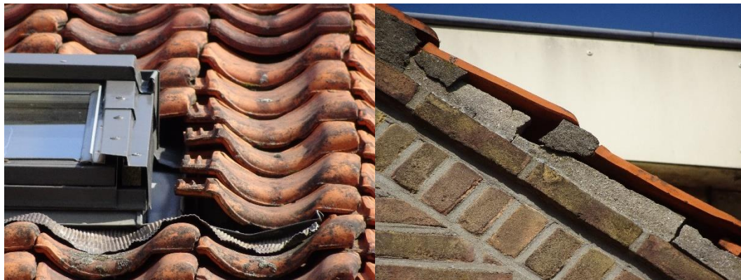
Figuur 3.4 Openingen onder dakpannen van het complex 5009 in Sassenheim
