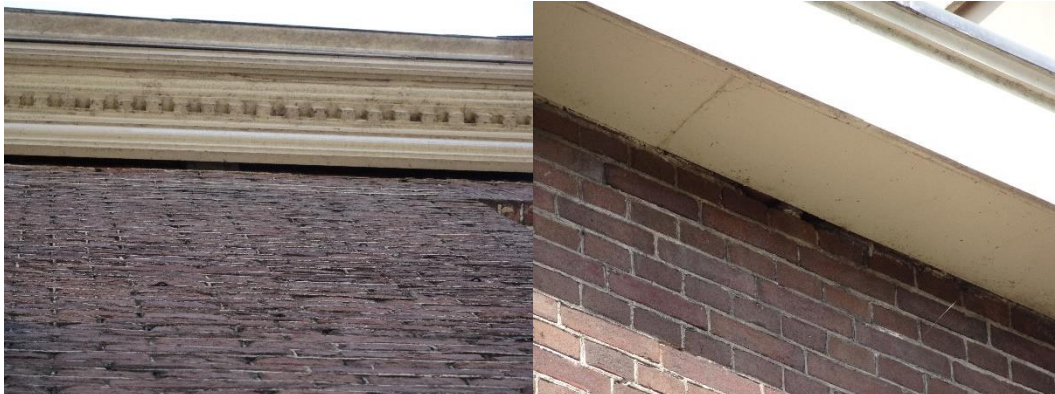
Figuur 3.1 Openingen onder daklijst en dakoverstek van complex 4271 in Warmond
