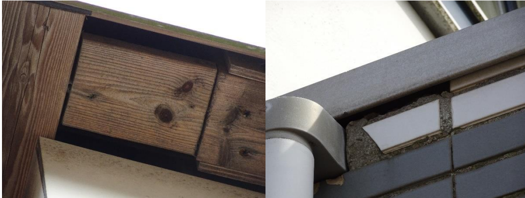
Figuur 3.10 Opening onder dakoverstek en opening onder daklijst in kantoorpand P069 in Noordwijk
