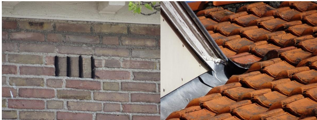
Figuur 3.3 Ventilatievoegen en opening onder loodflap in complex 5009 in Sassenheim
