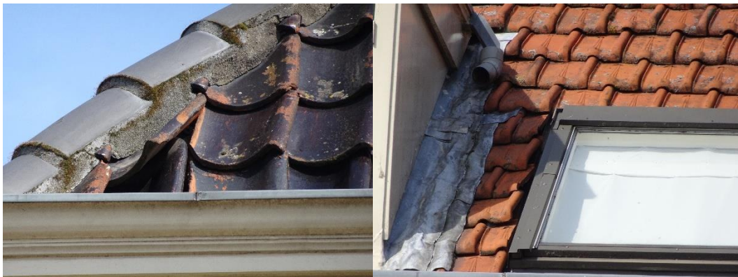
Figuur 3.2 Openingen onder dakpannen van complex 4271 in Warmond
