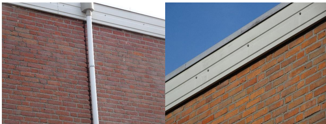
Figuur 3.6 Dilatatievoeg achter regenpijp en ruimte onder daklijst in complex 5022 in Sassenheim
