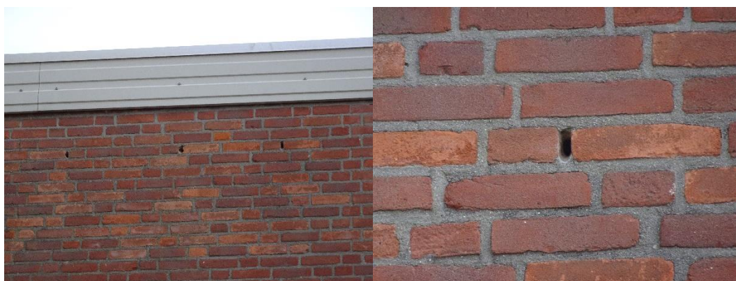
Figuur 3.7 Open stootvoegen in complex 5022 in Sassenheim
