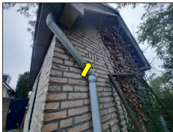
Figuur 12. Voorbeeld van open stootvoegen.
