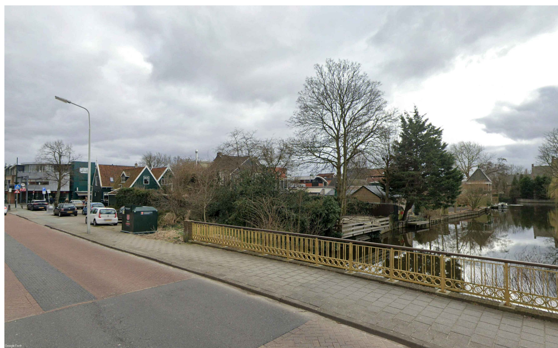
foto's bestaande situatie
