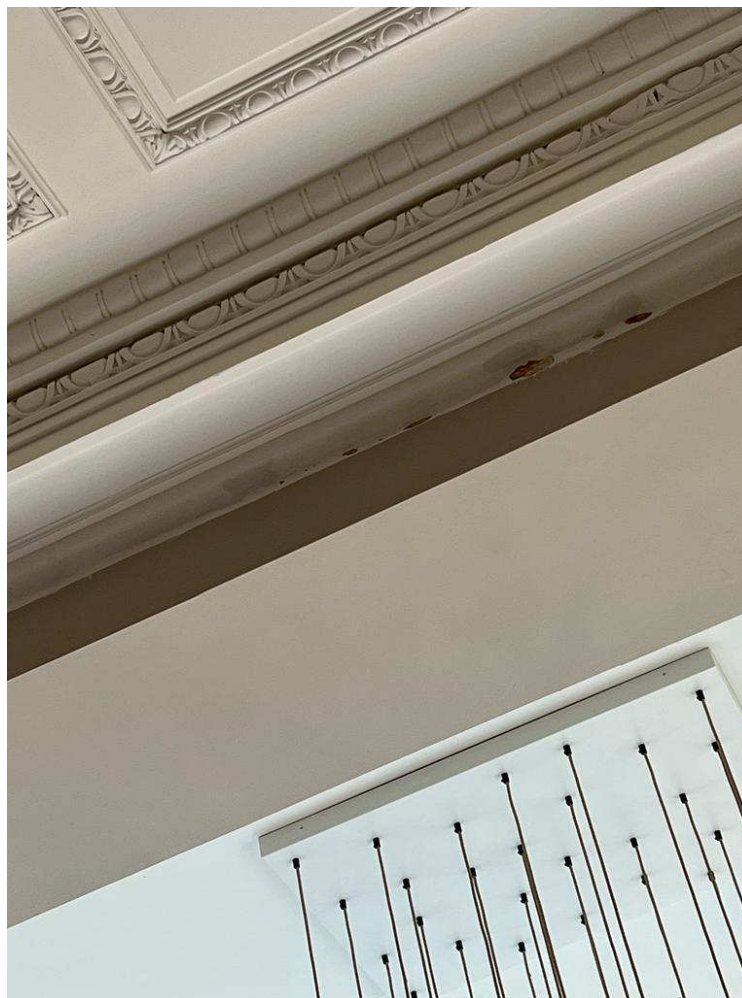
Foto 43 Waterschade stucplafond Bel etage Koningin Emmaplein 12
