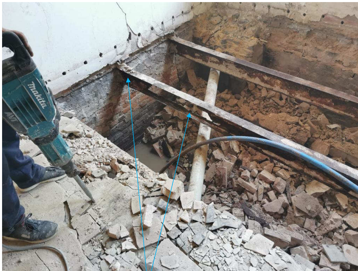
Foto 05 Bestaande toestand Totaal doorgerotte houten vloer in het Souterrain Koningin Emmaplein 12
