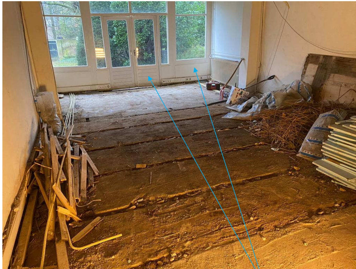
Foto 04 Bestaande toestand Totaal doorgerotte houten vloer in het Souterrain Koningin Emmaplein 12
