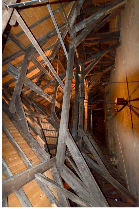
22. Grote Kerk, zolder boven de kerkzaal vanuit het noordwesten; de kapconstructie bestaat uit stapelspanten, die zijn opgebouwd uit jukken met daarop sporen- of A-spanten, 2023.
