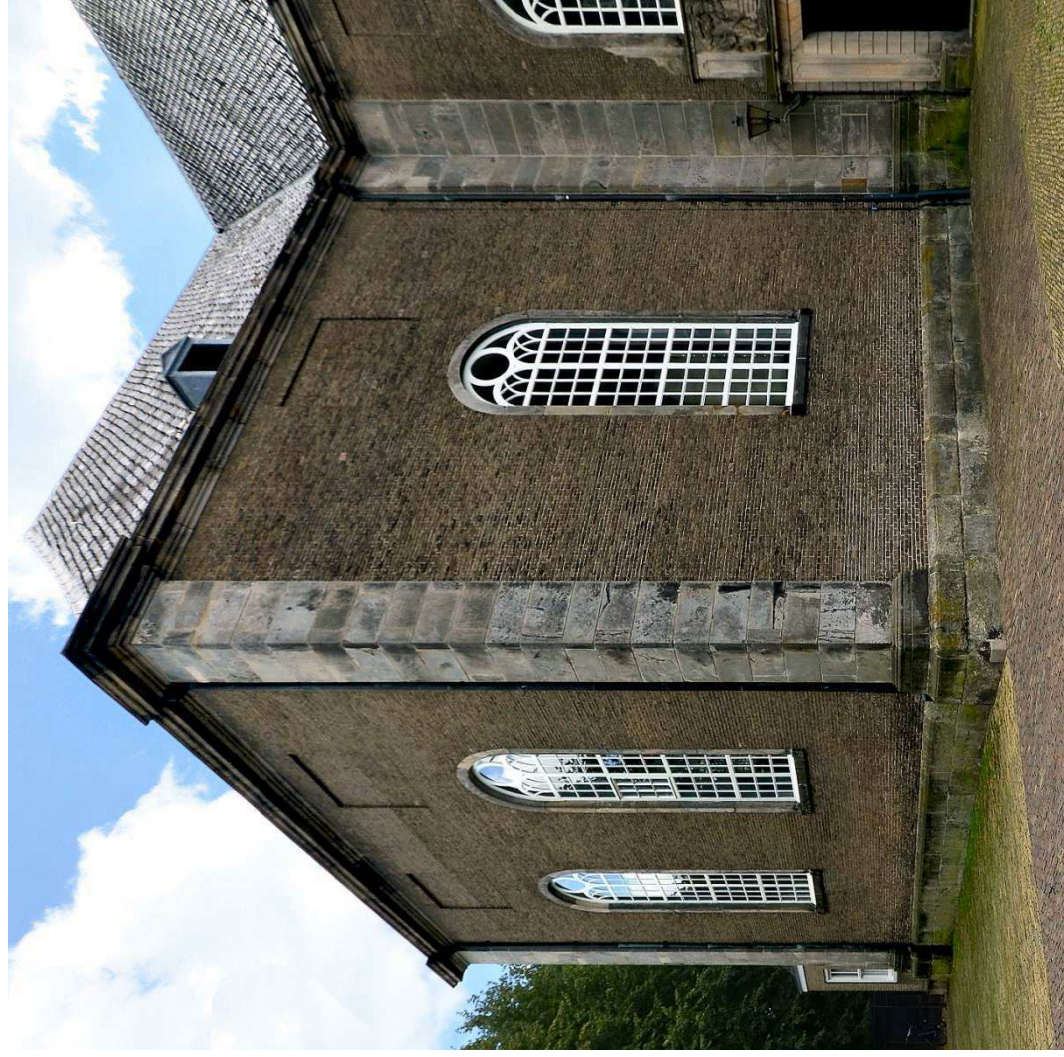
137. Noordarm vanuit het noordwesten; de gemetselde gevels zijn op de hoeken en bij de plinten en daklijsten verrijkt met Bentheimersteen.
