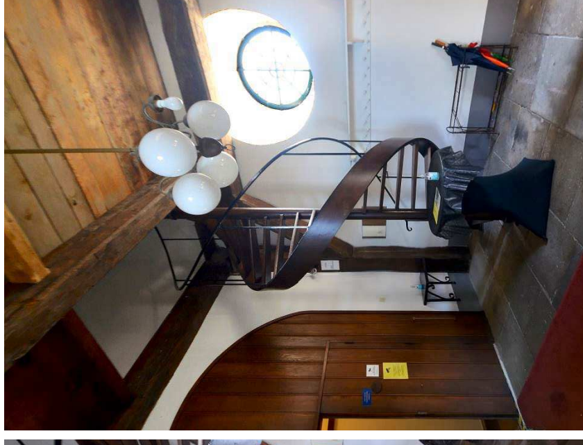
145. Toren, de spiltrap in de zuidoosthoek naar ontwerp van Sijmons en Schiere, die omstreeks 1955 nog in de noordwesthoek was gepland; de trap leidt naar het orgelbalkon en de verdiepingen van de toren.
