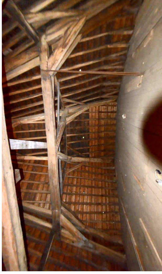
19. Grote Kerk, zolder boven het koor aan de oostzijde; waar zich nog twee halfspanten bevinden; het dakbeschoot is vernieuwd, 2023.
