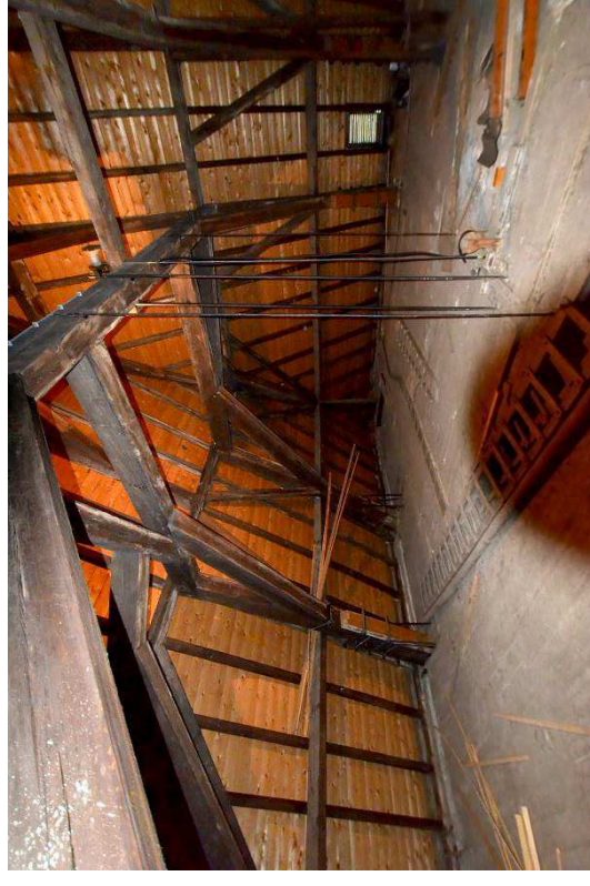
24. Grote Kerk, zolder boven de noordarm vanuit het zuidoosten; de grenenhouten kap uit 1738-1740 en een aantal secundaire trekstangen, 2023.
