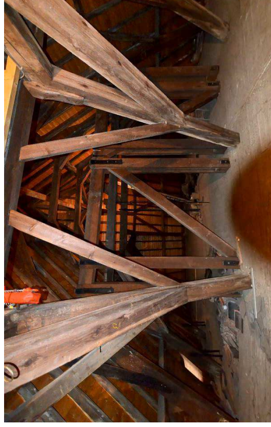
22. Grote Kerk, zolder boven de kerkzaal vanuit het noordwesten; de kapconstructie bestaat uit stapelspanten, die zijn opgebouwd uit jukken met daarop sporen- of A-spanten, 2023.
