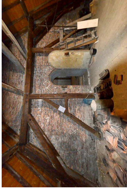
24. Grote Kerk, zolder boven de noordarm vanuit het zuidoosten; de grenenhouten kap uit 1738-1740 en een aantal secundaire trekstangen, 2023.
