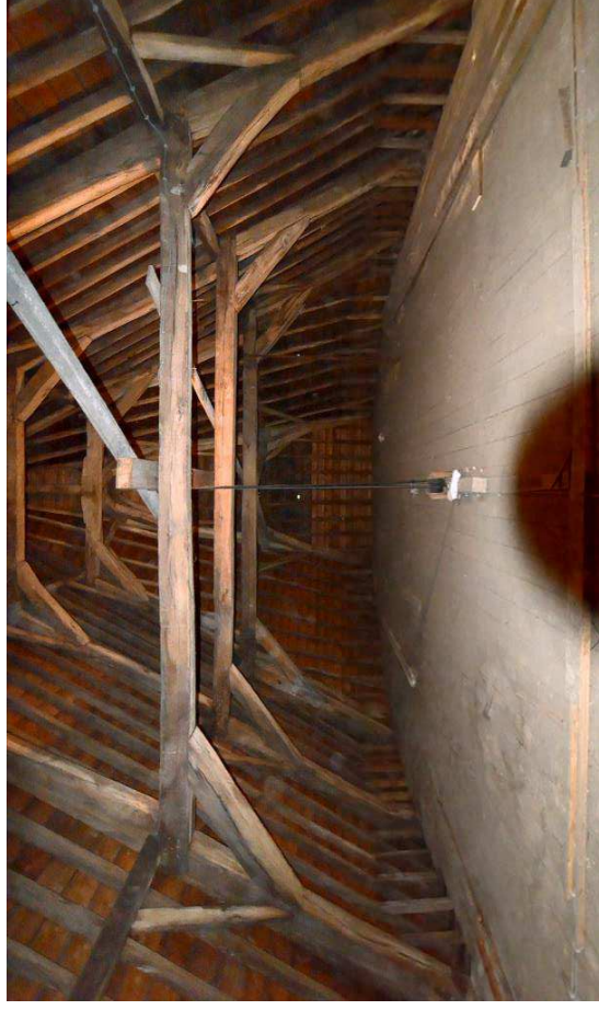
17. Grote Kerk, zolder boven het koor vanuit het westen; de eikenhouten kap stamt uit 1493-1499, maar de vloer is in 1955-1957 vernieuwd, 2023.
