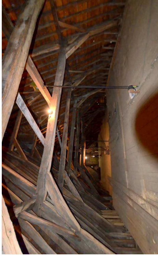
17. Grote Kerk, zolder boven het koor vanuit het westen; de eikenhouten kap stamt uit 1493-1499, maar de vloer is in 1955-1957 vernieuwd, 2023.
