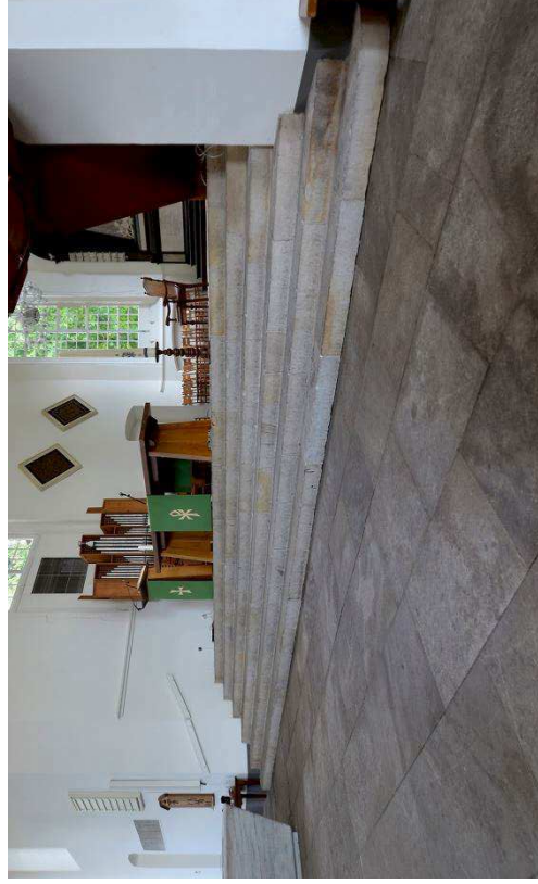
162. Kruising, de koortrap van Duitse kalksteentegels (Gernsheimer Blaubank) stamt uit 1956-1957, evenals de vloertegels van dezelfde steen van de kerkzaal.
