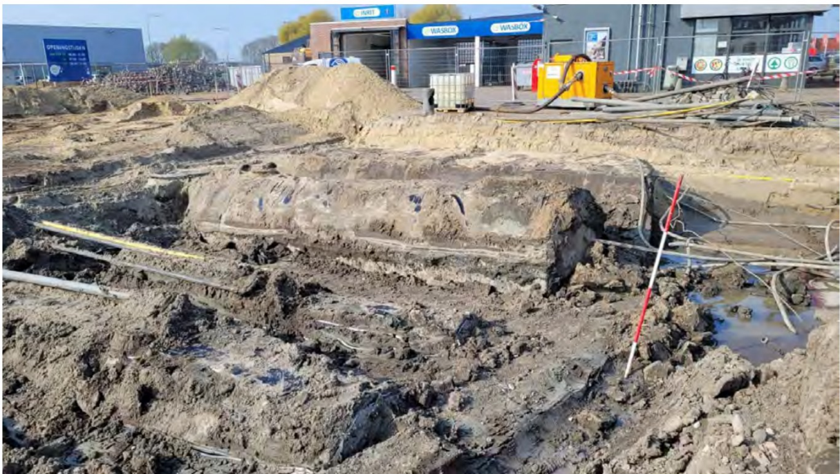
Afbeelding 2: Aangetroffen ondergrondse tanks.
