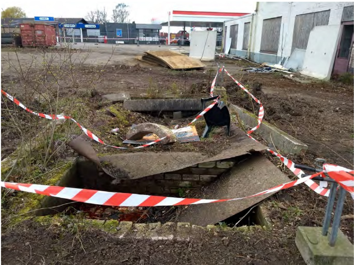
Afbeelding 8: Eén van de putten op het achterterrein.
