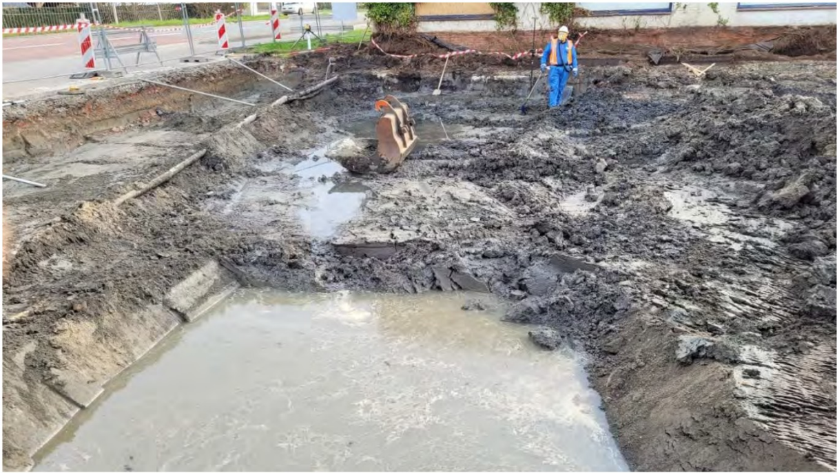
Afbeelding 5: Start bodemsanering op het noordwestelijk deel van de saneringslocatie.
