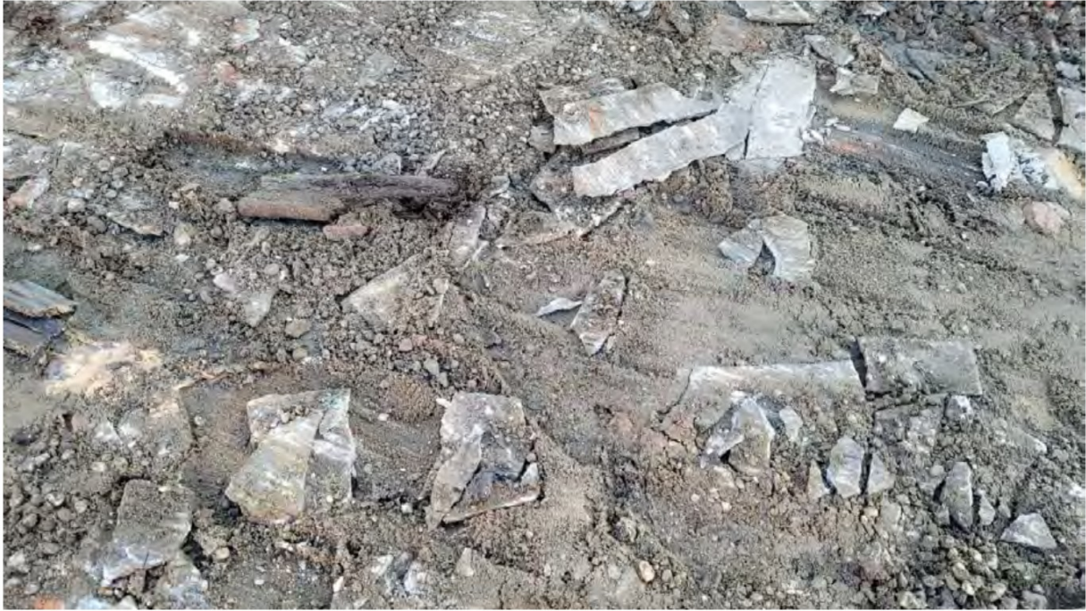
Afbeelding 1: aangetroffen asbestverdacht materiaal.
