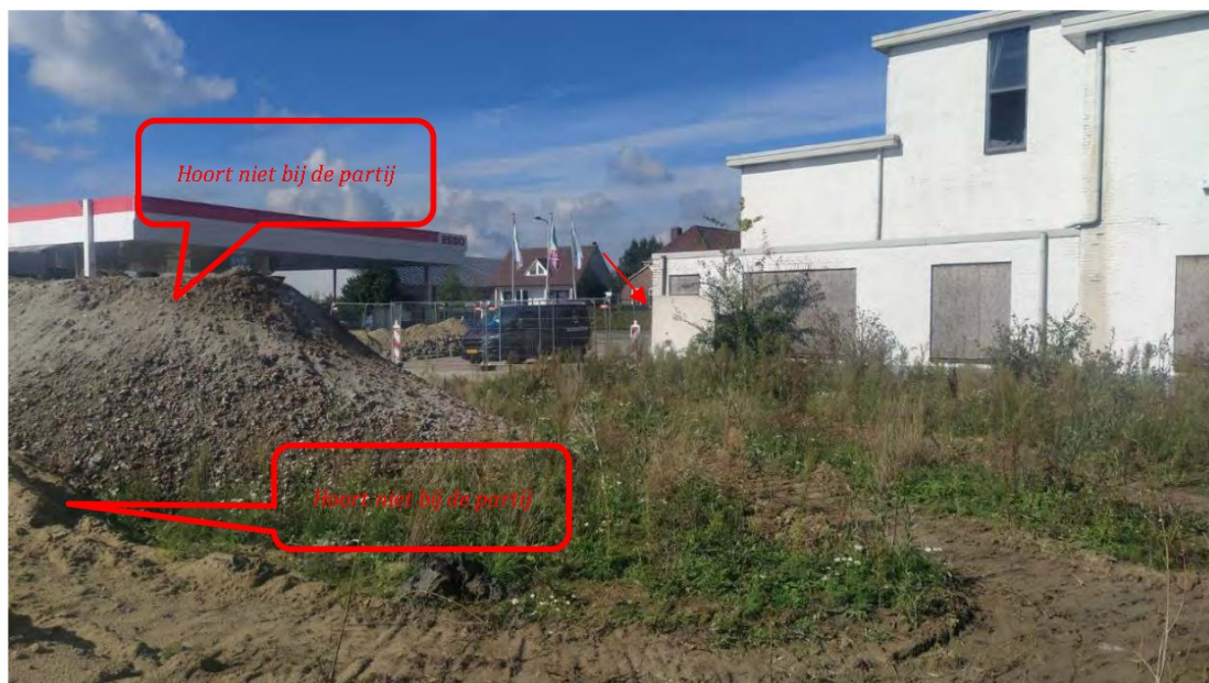
Foto 3: vast punt (hoek pand, rode pijl)
