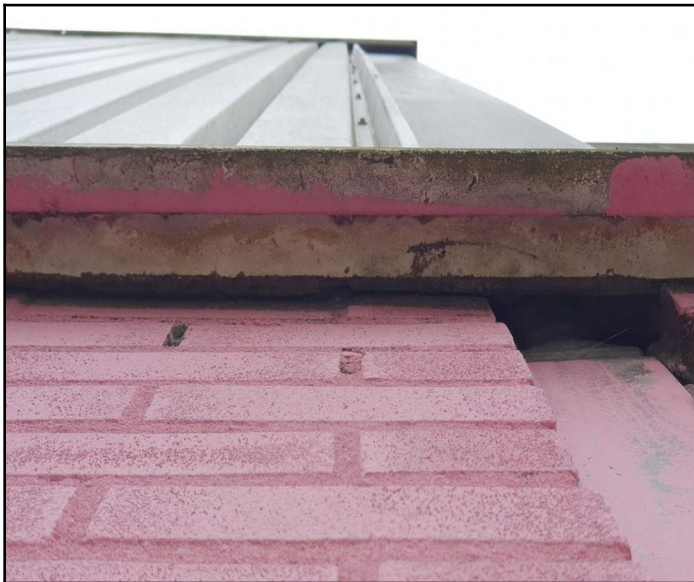
Afbeelding 10: Kieren tussen de muur en de gevelbeplating.
