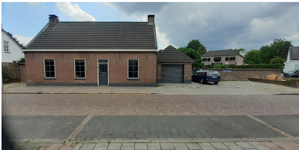
Figuur 5: Voorgevel bestaande woning Kapelstraat-Zuid 35 met garage, inrit, parkeerplaats en muur met gemetselde bloembak aan perceel de Kapelstraat Zuid 35 A.
