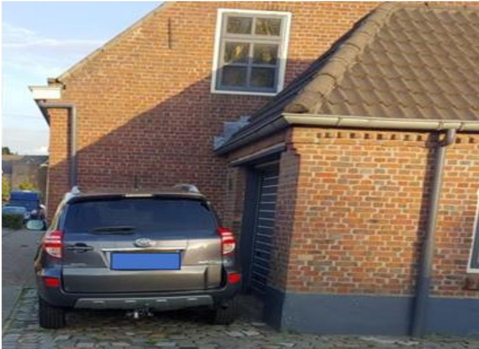
Figuur 10: Markante gebouwhoeken van Kapelstraat zuid 35 met fraaie zichtlijnen en schaduwvlakken die gehandhaafd blijven.
