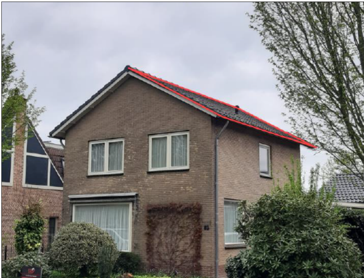
Figuur 1: woning aan de Anreperstraat 85 in Assen met rood omkaderd het te vervangen dakvlak (bron: natuurtoetsrapportage)
