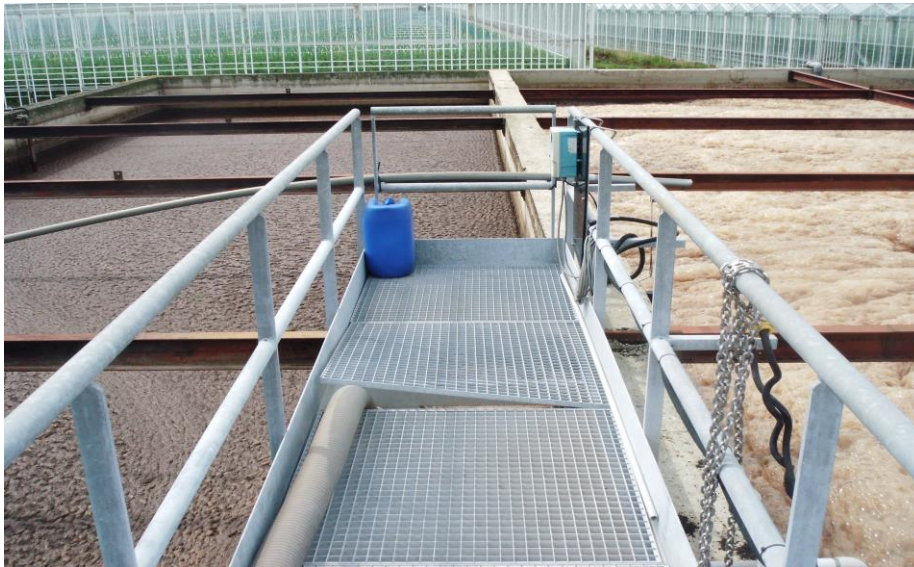
Figuur 10 Vlaamse installatie voor nitrificatie (met beluchting, rechts) en denitrificatie (links) voor dunne fractie varkensmest. Het blauwe vat bevat ethanol, extra koolstofbron voor de denitrificerende bacteriën.
