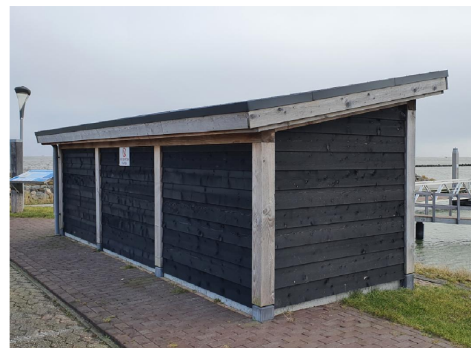
Bestaande naastgelegen overkapping
