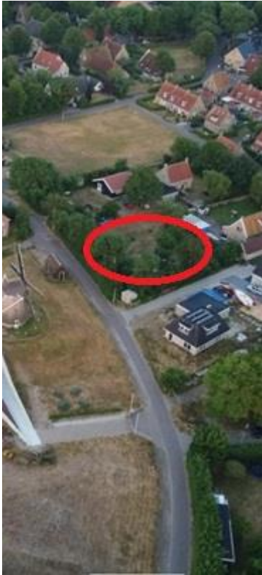
Figuur 3. Luchtfoto huidige situatie projectgebied aan de Molenweg.
