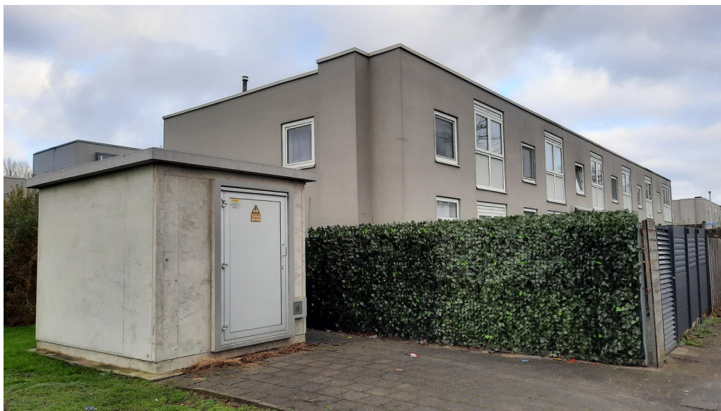
Het transformatorhuisje en woningen ten zuidoosten van het plangebied. Foto: M.M. Bouwmeester / Ecoresult B.V.
