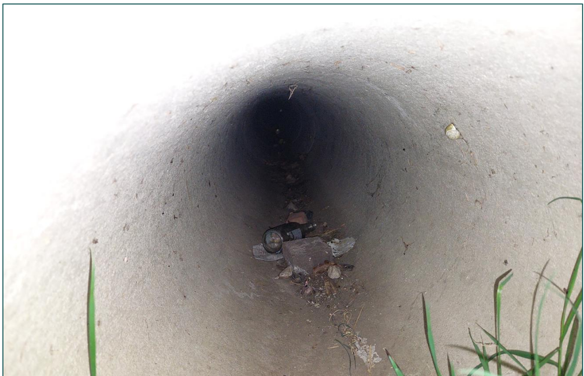
Figuur 4 De 'Vleermuis tunnel' beschikt over een doorlopende buis op maaiveld niveau.
