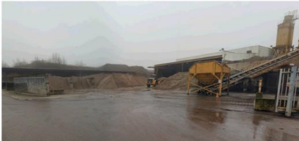
Foto: Streetview, Ingang ERI-terrein aan de Beemdweg
