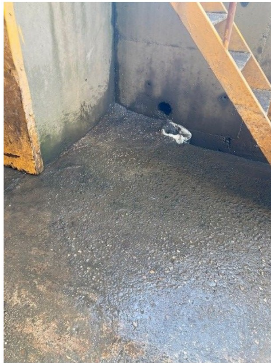
Foto 2-2 Vml. goot buitenzijde ERI-gebouw
