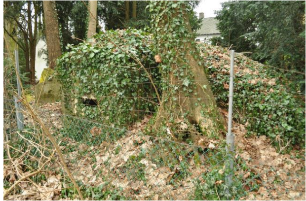
▲ Noordelijke zijde van de gevechtsschuilplaats met een zichtbare sleuf van een nis in de achterwand. Foto Leo van Midden 2013
