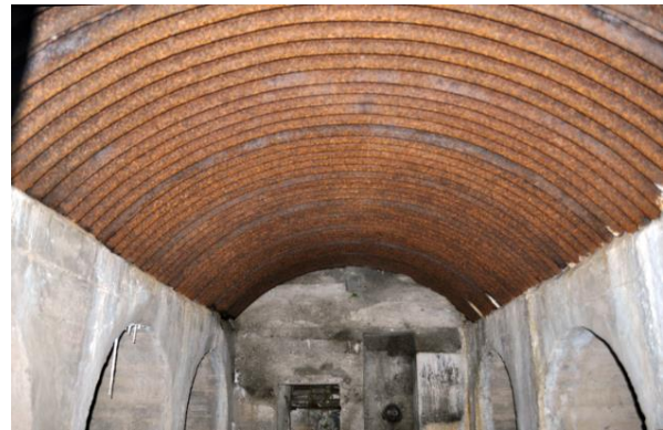
▲ Het interieur van de schuilplaats met het 'Wellblech'dak van het type 'Heinrich'. Foto Leo van Midden 2013
