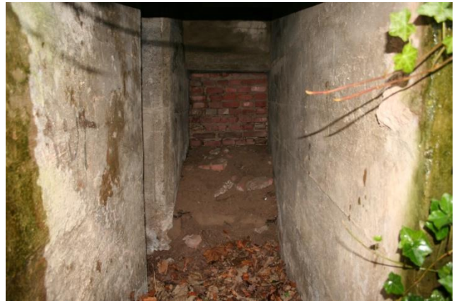
▲ Van de twee tegenoverliggende ingangen van de groepsschuilplaats bij Huis Baank is één zijde dichtgemetseld. Links de toegang tot de centrale ruimte. Foto gemeente Zutphen 2006.
