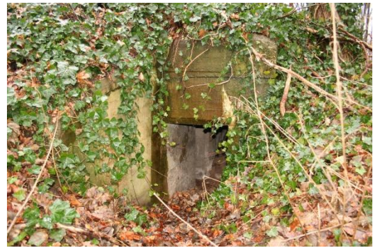
▲ De toegang tot de groepsschuilplaats ligt binnen dieper dan de buitentoeegang. Foto gemeente Zutphen 2006
