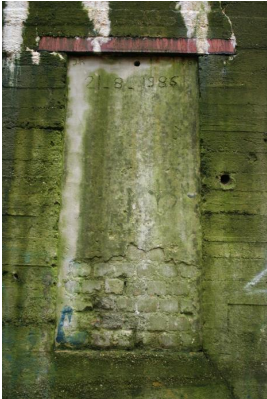
▲ De linker toegang van de bunker is in 1986 dichtgemetseld. Foto gemeente Zutphen 2006
