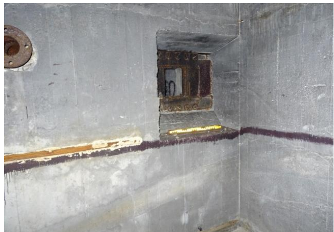
▲ Schietopening met luik en ventilatiegat (links) tussen de linker ingang en de centrale groepsruimte. Foto W. Harmelink 2019
