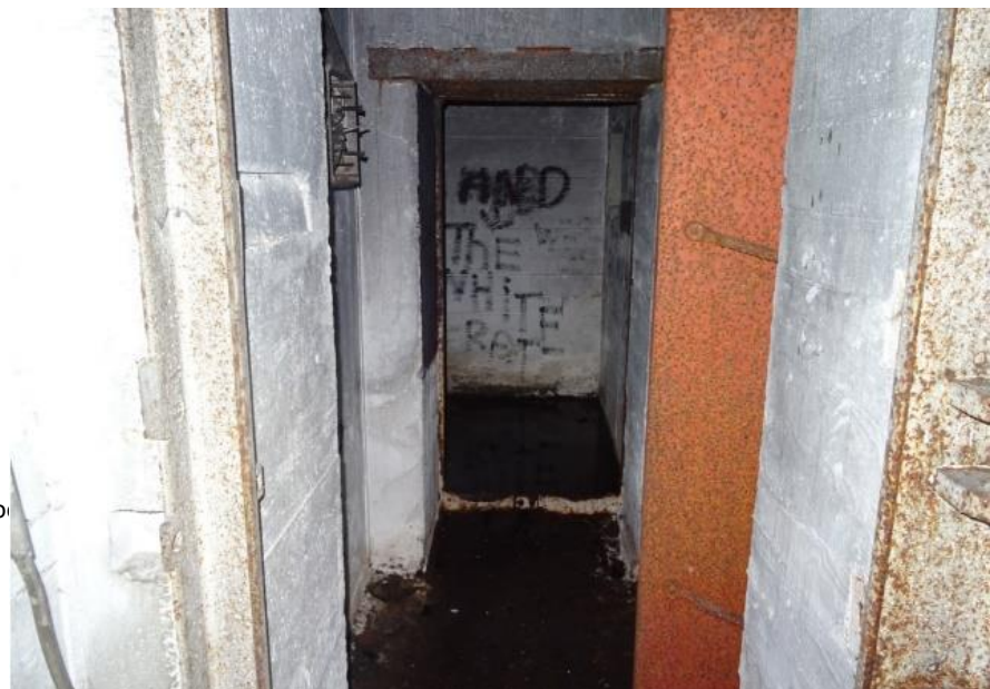
▲ Schietopening met luik en ventilatiegat (links) tussen de linker ingang en de centrale groepsruimte. Foto W. Harmelink 2019
