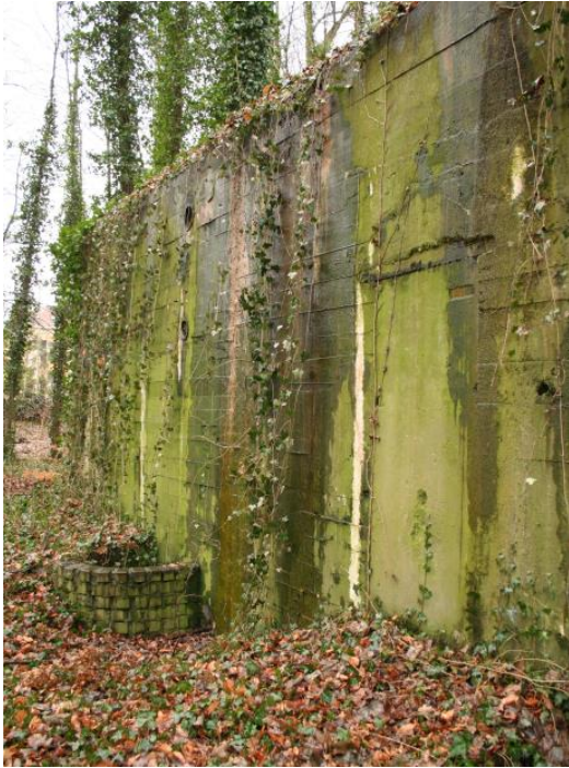
▲ De oostzijde (keelzijde) van de bunker met rechts een van de twee dichtgemetselde toegangen. Links, boven elkaar twee ronde ventilatieopeningen en eronder een hoefijzervormig muurtje ter bescherming van een andere ventilatieopening. Foto gemeente Zutphen 2006
