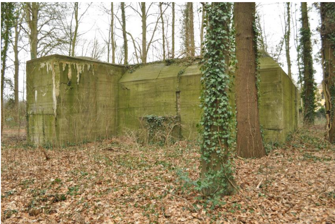
▲ De bunker in het bosperceel naast Huis Baank vanuit het noorden. Foto Leo van Midden 2013
