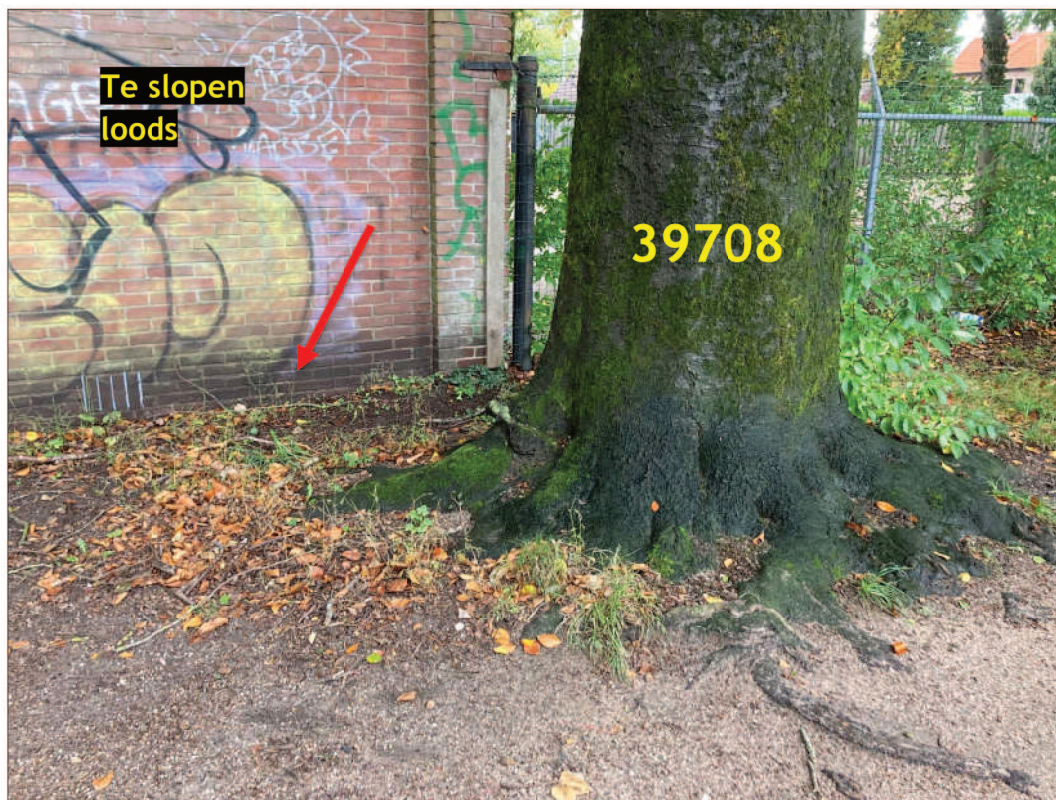
Afbeelding 35: Te slopen loods (fundering) binnen de bewortelbare zone. Pijl: risico wortelschade bij ontgraven fundering
