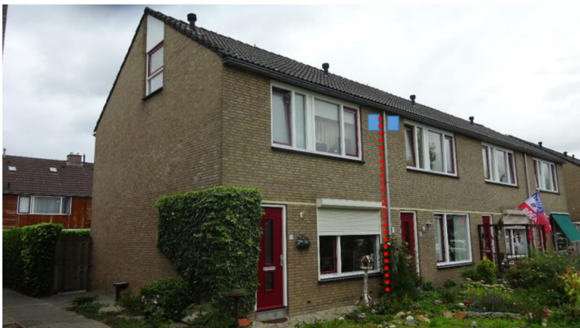
Figuur 2. Weergave van de toepassing van tijdelijke voorzieningen (blauw=vleermuiskast, rood=spouwmuurscheider).
