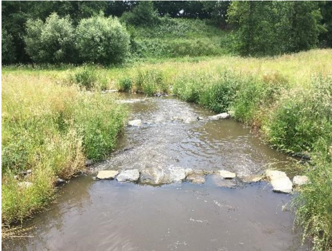
Hellingvispassage met bekkenstructuur Volmolen, IBFM (2021)
