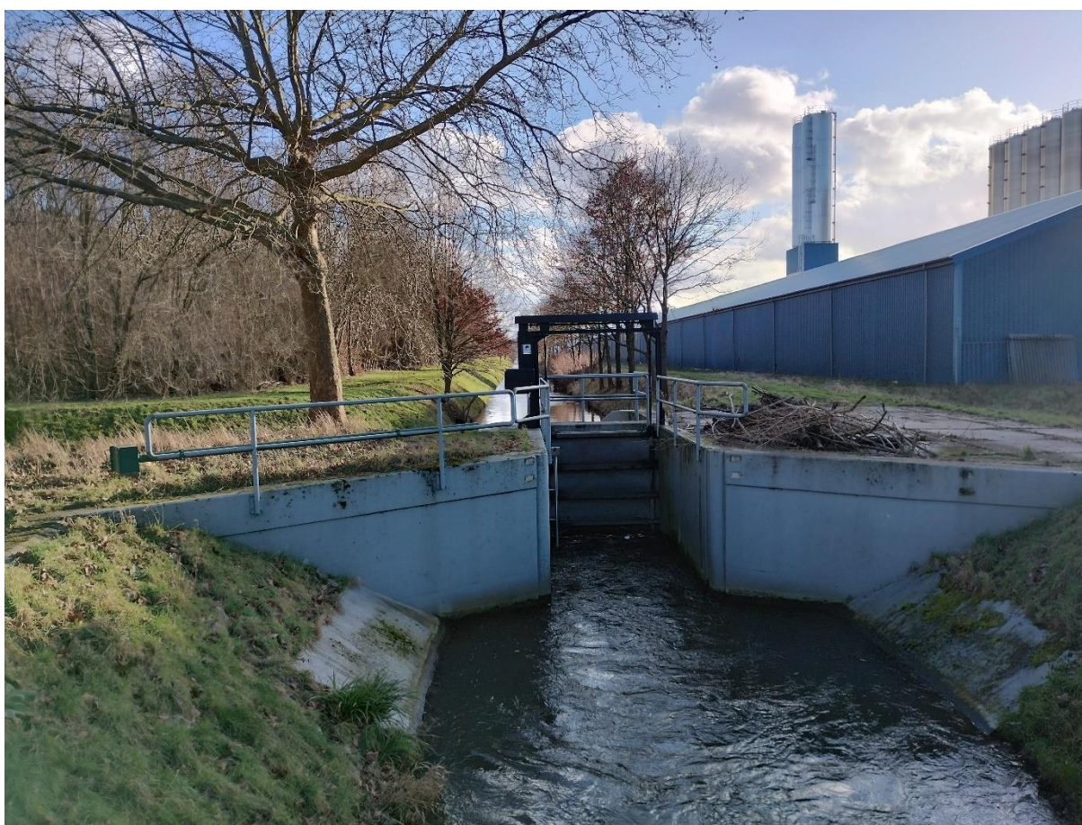
Figuur 9. Het verdeelwerk waar de Vloedgraaf zich afsplitst van de Geleenbeek (richting links). Een groot deel van het water uit de Geleenbeek wordt hier over de Vloedgraaf geleid. Op deze locatie is de vispassage gepland (foto: RAAP, 26-01-2024).
