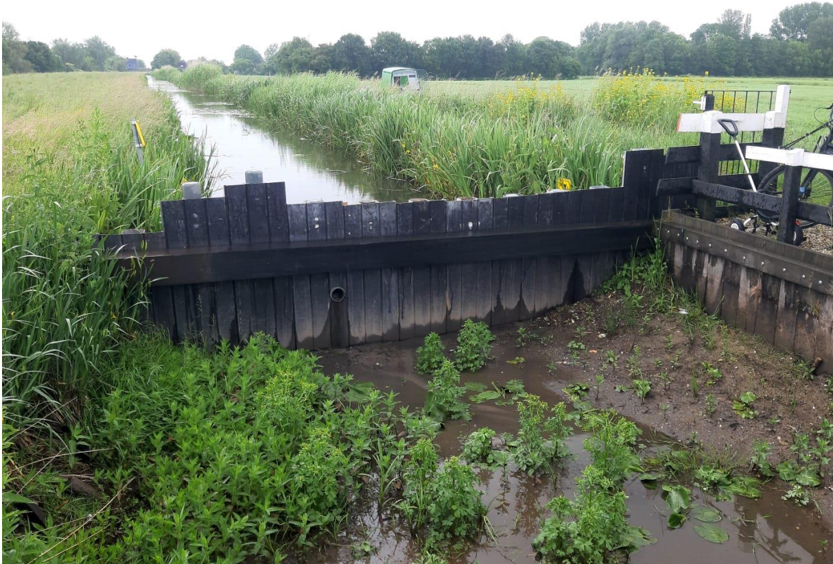
Kunststof afdamming met inlaat voorziening in het damwand
