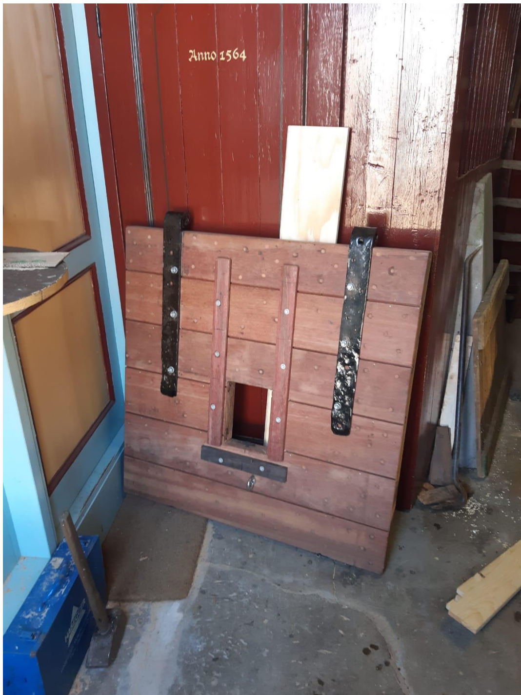
Archief foto van nieuwe gemaakte wachtdeur met inlaat voorziening
