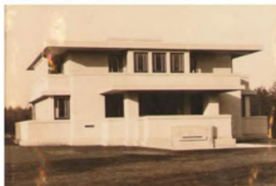
AFBEELDING 7, AANZICHT ACHTERGEVEL BIJ OPLEVERING
