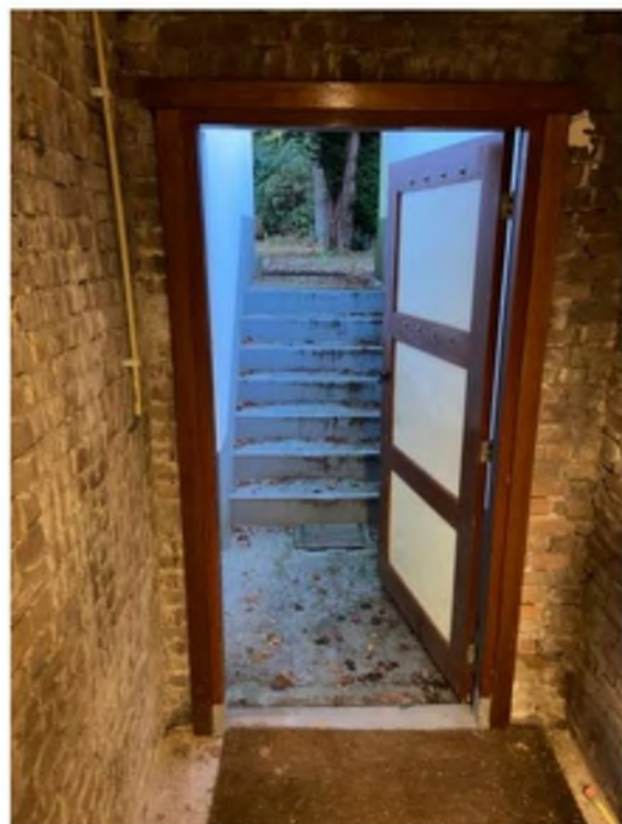
AFBEELDING 25, TOEGANG KRUIPRUIMTE MET TRAP
