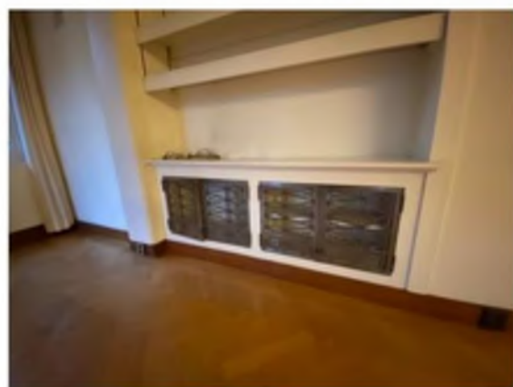
AFBEELDING 63, VOORMALIGE RADIATORCAST MET DEUREN ALS HAARDSCHERM
