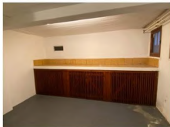
AFBEELDING 33, KELDER MET WERKBLAD OP LATTENWAND EN PLAVUIZEN AFWERKING
