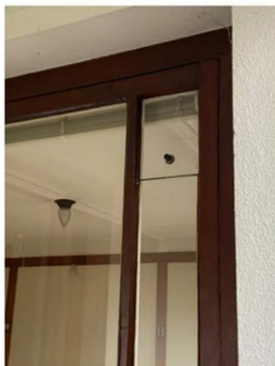
AFBEELDING 69, DETAIL VENTILATIERUITJE
