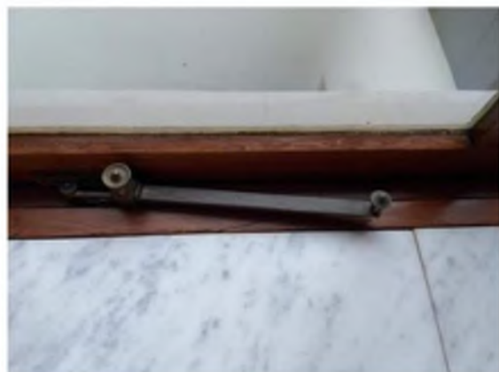
AFBEELDING 42, UITZETTER KEUKENRAAM OOSTGEVEL
