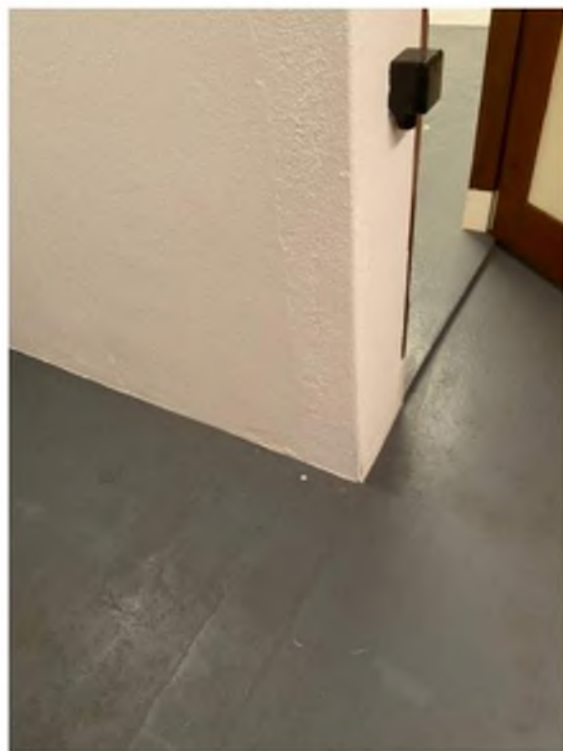
AFBEELDING 35, AFTEKENING VERWIJDERDE WAND KLUISRUIMTE
