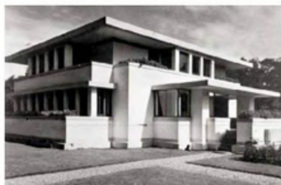
AFBEELDING 10, AANZICHT WESTELIJKE ZIJGEVEL EN ACHTERGEVEL JAREN VUFTIG
