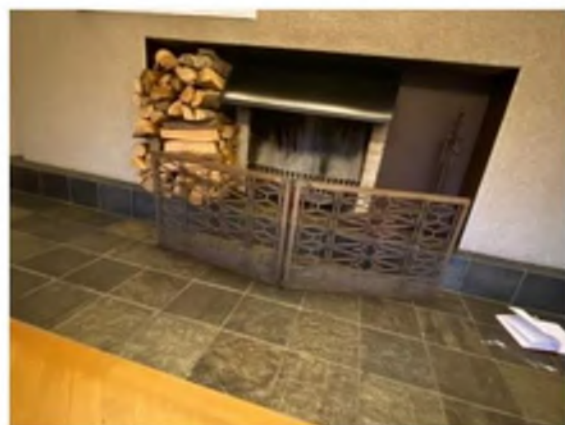
AFBEELDING 62, HAARD MET MESSING SCHERM EN KWARTSIET VLOERTEGELS
