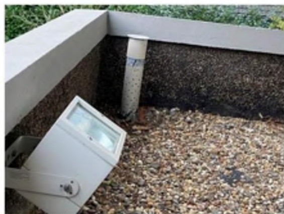
AFBEELDING 24, DOORVOER PLATTE DAK BLOEMBAK MET FILTERGAATJES
