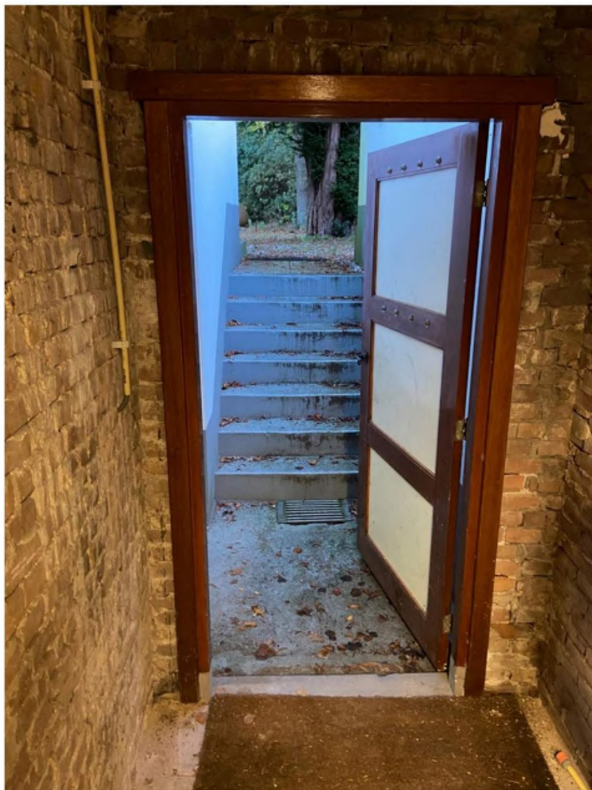
Toegang kruipruimte en kelder
