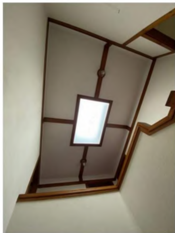
AFBEELDING 95, PLAFOND BOVEN TRAP
