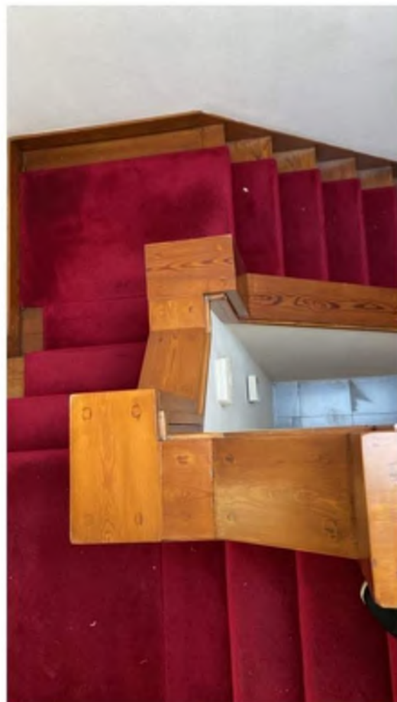
AFBEELDING 96, TRAP MET BALUSTRADE
