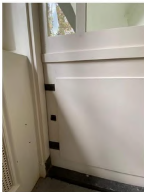
AFBEELDING 74, DEUR NAAR BALKON MET KANTSCHUIVEN
