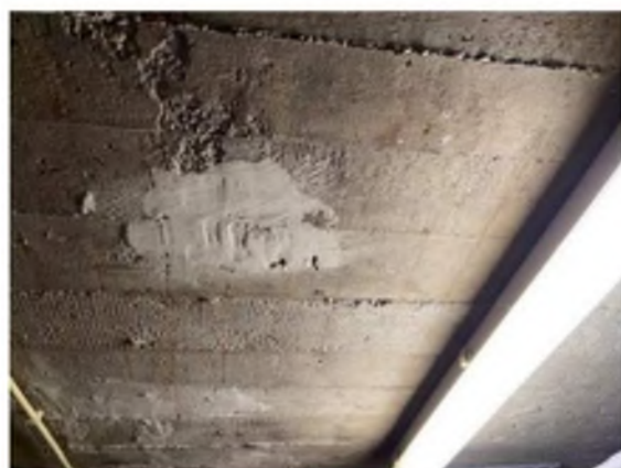
AFBEELDING 27, ONDERZIJDE BEGANE GRONDVLOER
