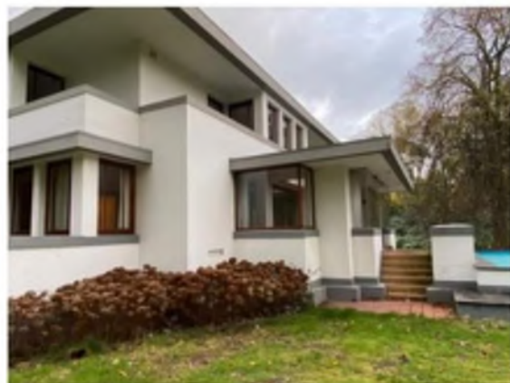
AFBEELDING 5, HOEK WESTELIJKE ZIJGEVEL MET ACHTERGEVEL
