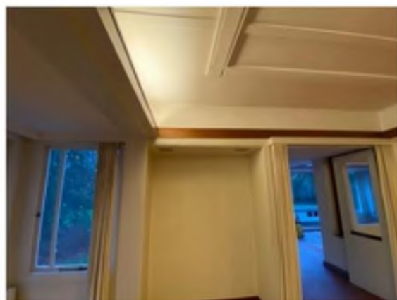
AFBEELDING 60, AANZICHT PLAFOND EN NIS BIJ VOORMALIGE RADIATORSCHACHT
