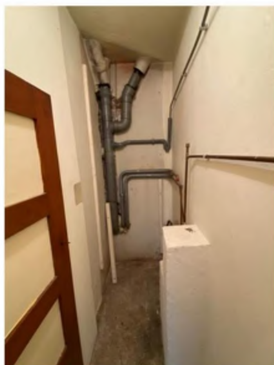
AFBEELDING 73, VOORMALIGE TECHNISCHE RUIMTE NAAST BADKAMER
