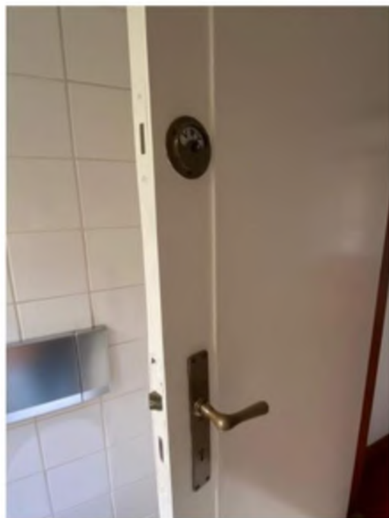
AFBEELDING 81, DEUR TOILET EERSTE VERDIEPING
