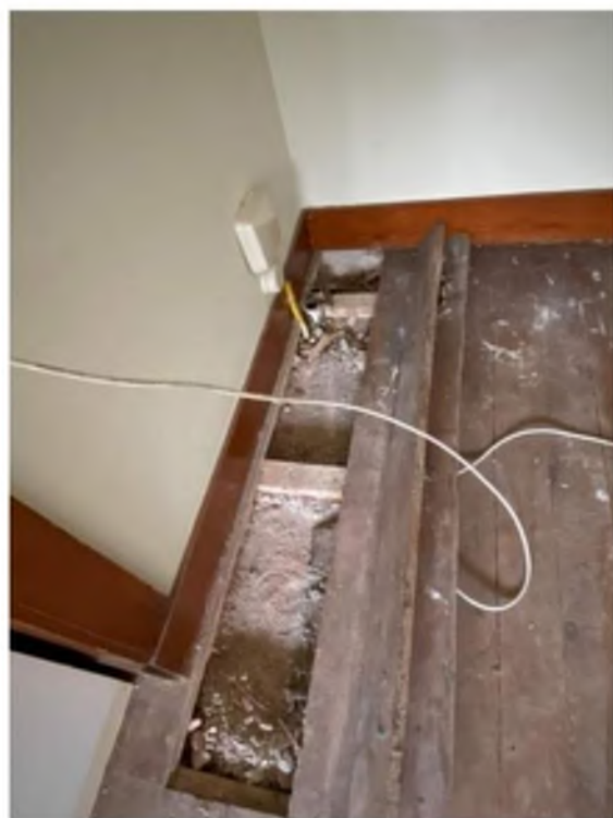
AFBEELDING 90, FRAGMENT VLOER MET LIGGERS IN BETON
