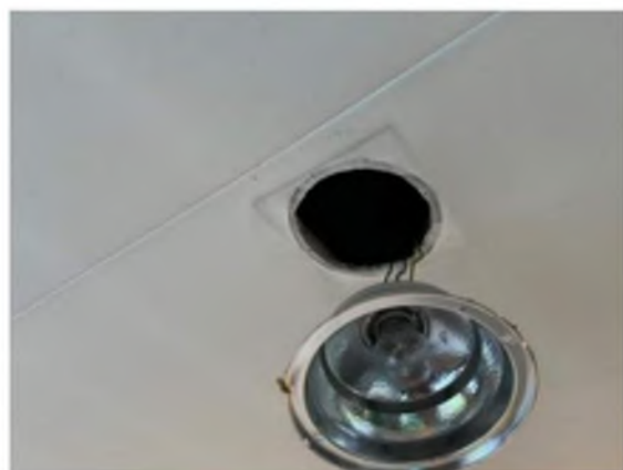
AFBEELDING 38, VERLAAGD PLAFOND GIPSPLATEN
