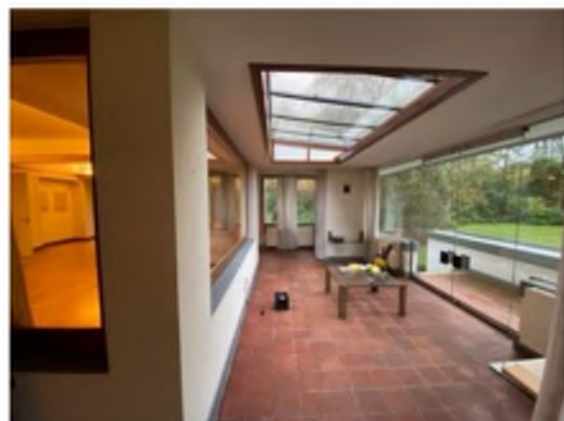
AFBEELDING 65, VERANDA MET LATER TOEGEVOEGD DAKLICHT
