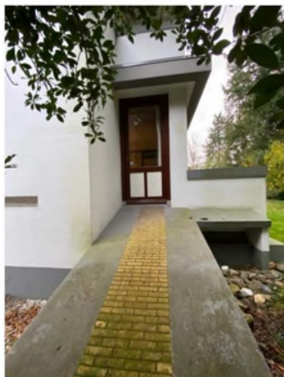
AFBEELDING 21, HELLINGBAAN RECHTERZIJDE NOORDGEVEL
