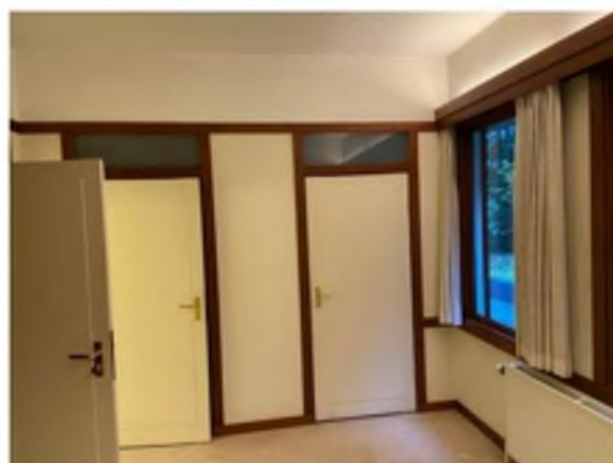
AFBEELDING 57, PANEELDEUREN STUDEERKAMER MET BEPLATING
