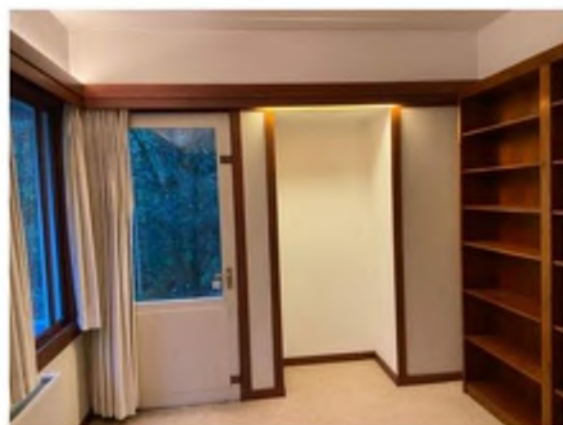
AFBEELDING 58, NIS IN VOORMALIGE RADIATORSCHACHT
