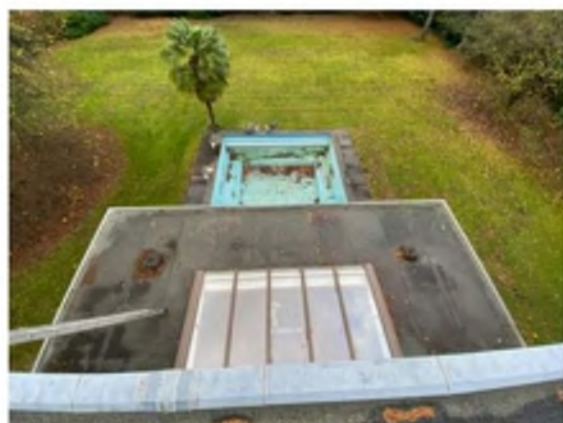
AFBEELDING 23, AANZICHT DAK LUIFEL MET DAKLICHT EN VIJVER
