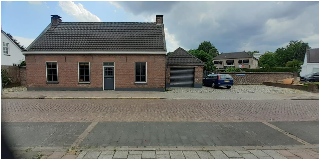
Figuur 5: Voorgevel bestaande woning Kapelstraat-Zuid 35 met garage, inrit, parkeerplaats en muur met gemetselde bloembak aan perceel de Kapelstraat Zuid 35 A.
