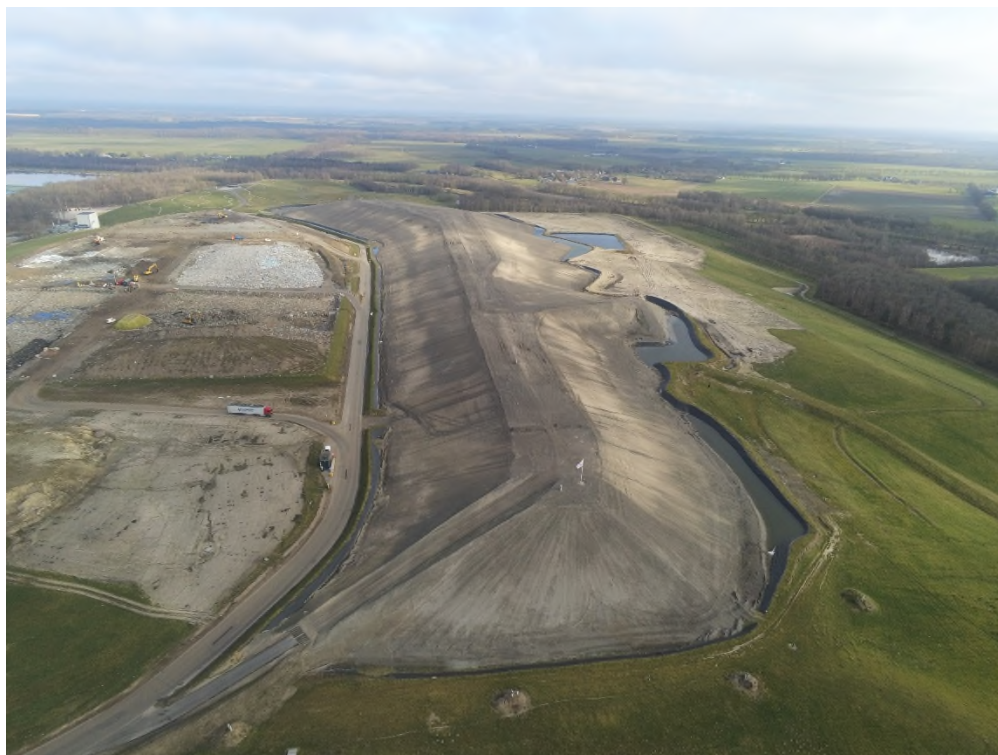
Figuur 1.1 Situering bovenafdichting Attero Wijster
