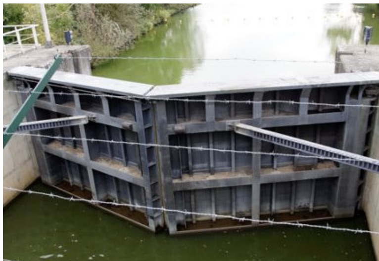
Figuur 2-3: Foto van de stalen puntdeuren
