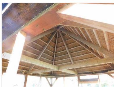
Figuur 5.2 Opstal met aan de binnenzijde rieten dakbedekking en steunbalken.
