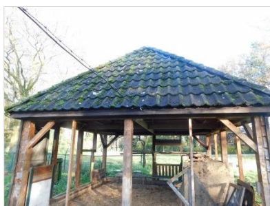
Figuur 5.1 Opstal met wolfsdak bedekt met dakpannen.
