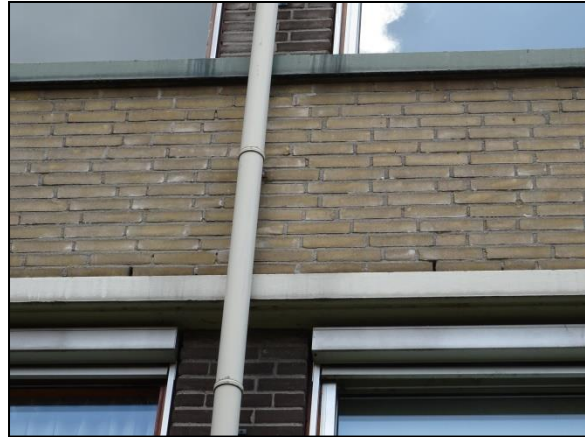
Figuur 10. Ruimte achter daktrim en zonwering.
