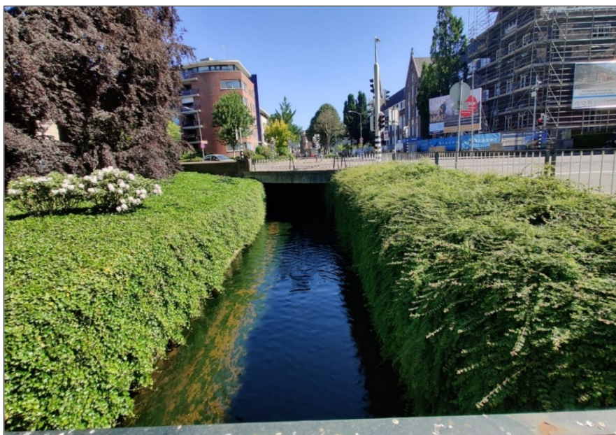
Figuur 4: Kruising Parklaan, Engelenkampstraat, Wilhelminastraat. Met zicht op de zuidkant van het overkluisde deel.
