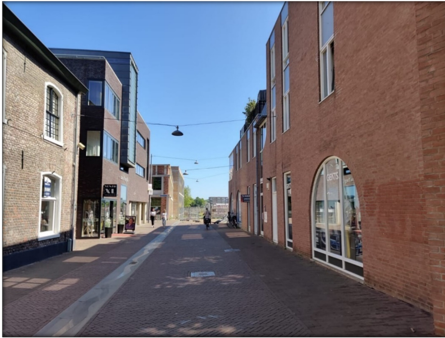
Figuur 5: Haspelsestraat, overkluisd gedeelte.
