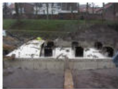
Bouw van de vleermuisbunker.
