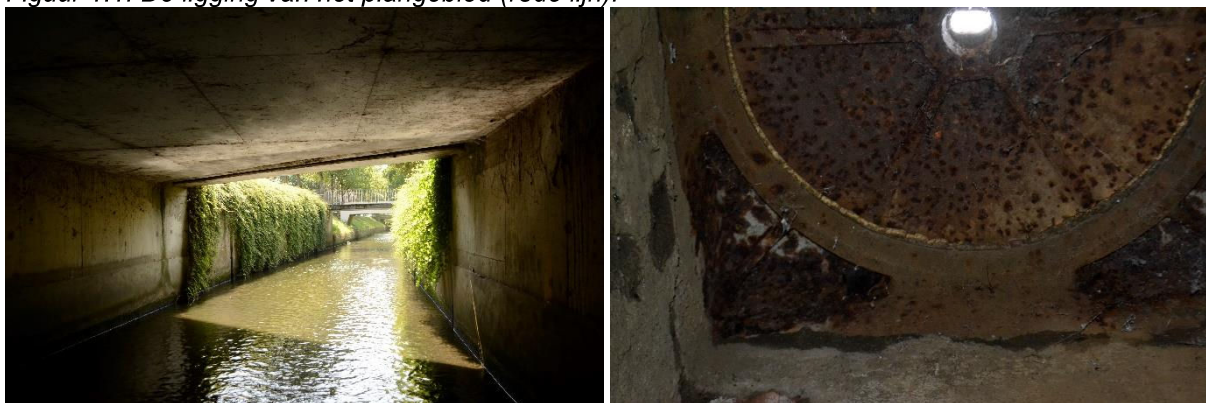
Figuur 1.2 Situatie van het plangebied met links zichtbaar ingang van de overkluizing en rechts een putdeksel.
