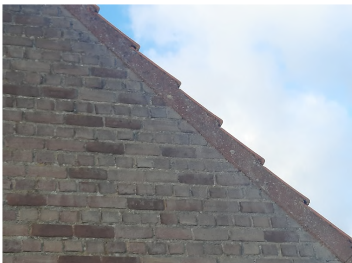
Figuur 5.2: Dakpannen van de schuur sluiten nauw aan op de buitengevel
