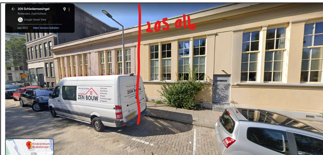
Fragment 2: geveloverzicht. Duidelijk is te zien, dat het om één gebouw gaat. Bron Google.
