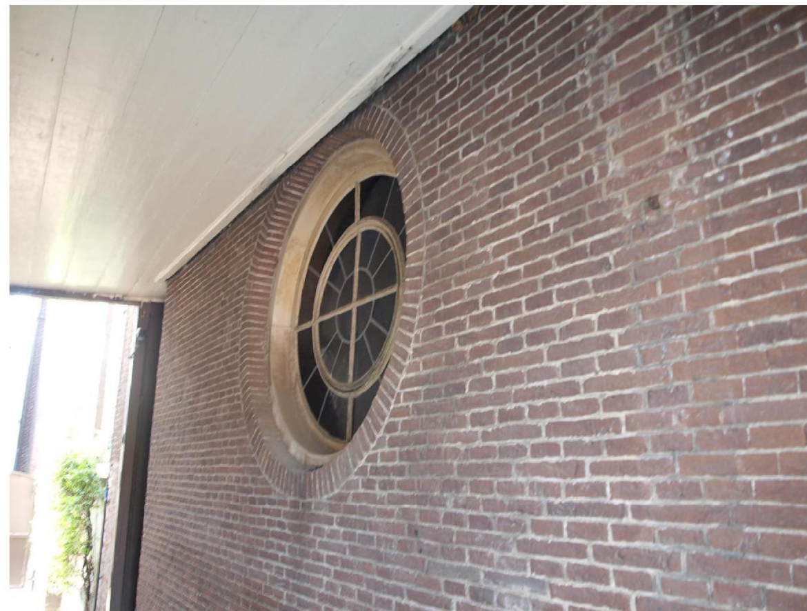
bestaande houten venster onder de overbouw van de steeg
