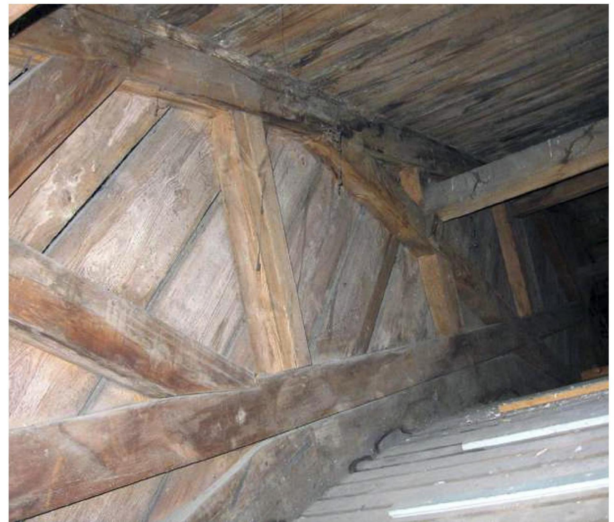
één van de bestaande houten dakspanten in de kerk
