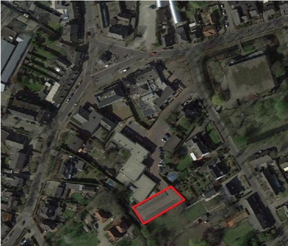
Ligging parkeerterrein ten behoeve van parkeren voor patiowoningen (parkeerterrein rood omlijnd) (bron: maps.google.com)
